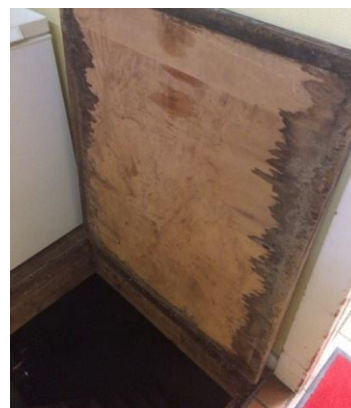
Billede 18: Entre, misfarvninger på kælderlem.
