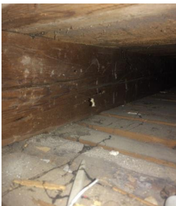
Billede 38: Skunkrum NØ, hulrum i etagedæk, under gulvbrædder.
