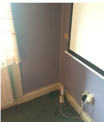
Billede 13: Mødelokale 2, fodpanel let nedbrudt.
