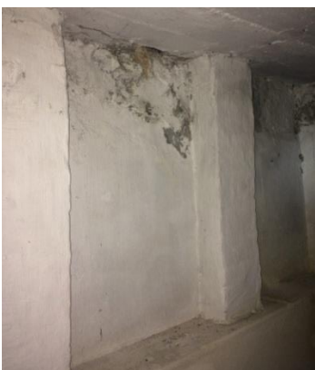
Billede 16: K3, kælder, misfarvninger og støbt loft.
