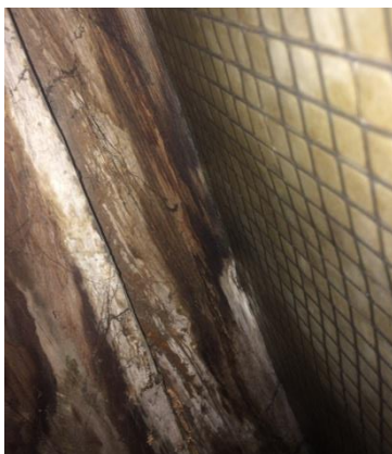
Billede 40: Skunkrum NV, misfarvninger på spær og plastikfolie.
