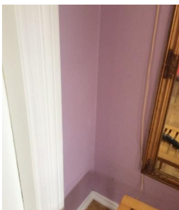
Billede 4: Lille opholdstue, træfugt op til 20 % i fodpanel. Nedre tapetseret væg Gann-værdi <100.
