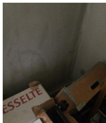
Billede 15: Mødelokale 1, hjørne opfugtet, nedre del af væg Gann-værdi 130, i 1m meters højde Gann-værdi 110.
