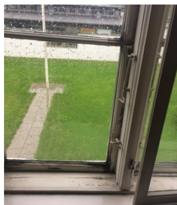
Billede 14: Mødelokale 2, Vinduesramme kraftigt nedbrudt, vandet trænger ind ved nedbør.
