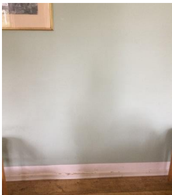
Billede 4: Lille opholdstue, træfugt op til 20 % i fodpanel. Nedre tapetseret væg Gann-værdi <100.
