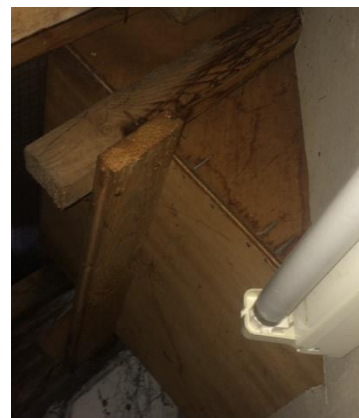
Billede 41: Skunkrum SV, misfarvning på bagside af ovenlysvindue.
