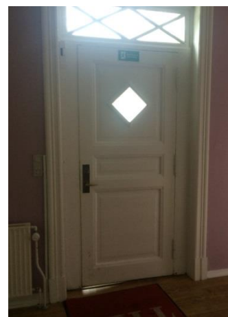
Billede 6: Lille opholdstue, træfugt i hjørne > 50 %, træfugt mellem hjørne og karnap ≤20 % i fodpaneler
