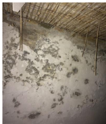
Billede 17: K3, kælder, misfarvning på væg, samt gammelt stråloft.
