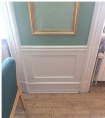
Billede 1: Stor opholdstue, træfugt i hvidt træpanel 20- >50 %.
