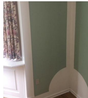
Billede 3: Lille opholdstue, træfugt i hjørnet på fodpanel <20 %.
