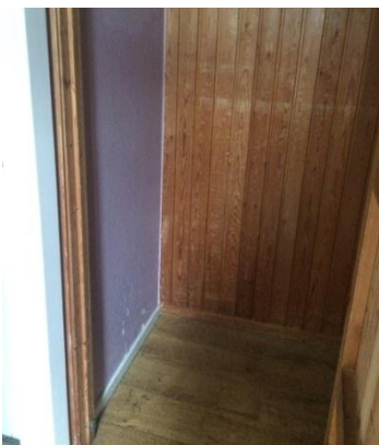
Billede 10: Garderobe, hvidt træpanel i hjørne træfugt op til 40 %, træpanelvæg op til 15 %.
